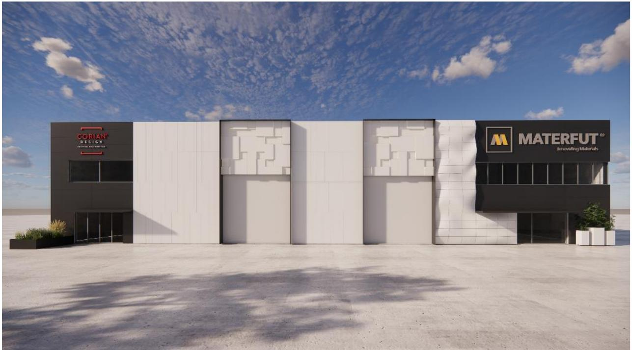
Firmensitz von Materfut®, Portugal. Die Fassade mit Corian® Exteriors Paneelen (hergestellt aus Corian® Solid Surface) greift verschiedene Gestaltungsansätze auf, einschließlich organisch geformter Module, die mit parametrischem Design erstellt wurden; Entwurf des Architekten Alexandre Sousa Lopes; Herstellung und Montage durch Materfut®; Bild von Materfut®, alle Rechte vorbehalten.
